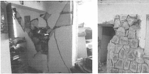
Şekil 3.4 D tipi hasarlı elemanlar
